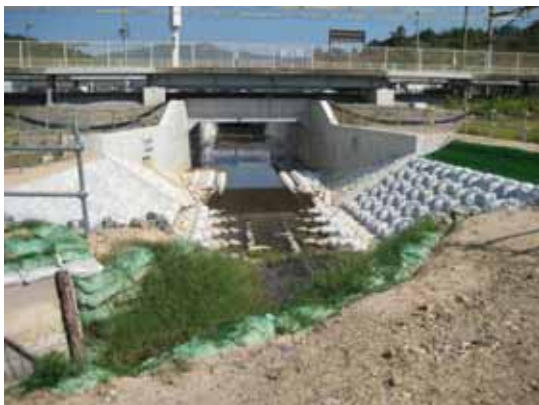
① JR 山陰本線吉富駅橋梁 改修後の状況
