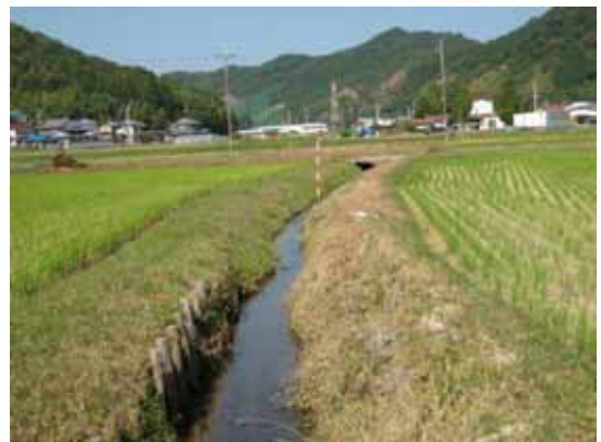
② 護岸工による改修予定箇所
