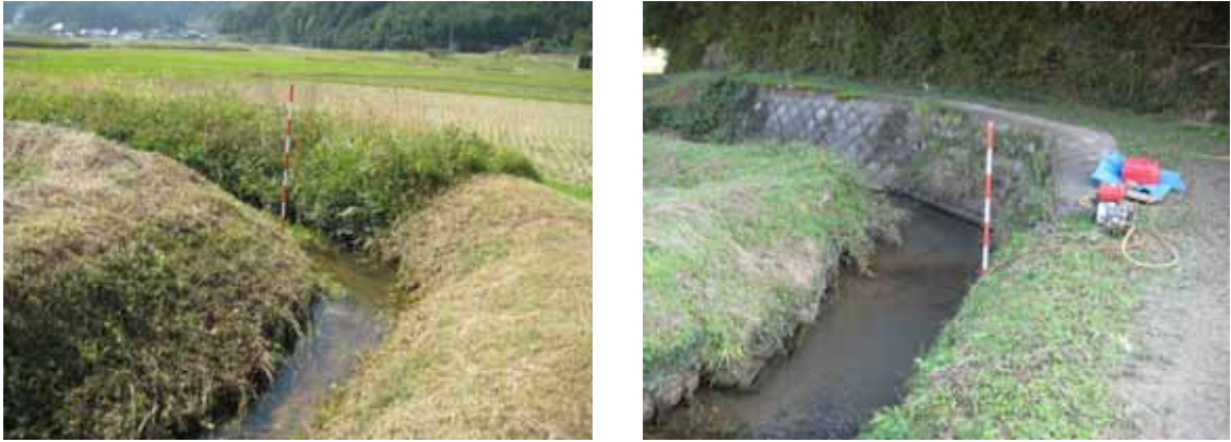
未改修区間の状況
