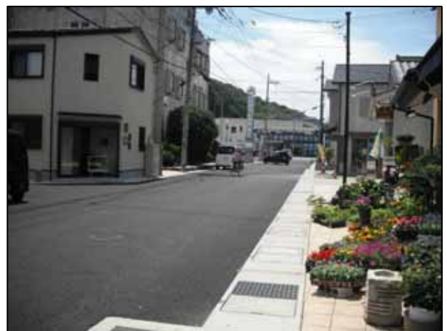
8 m区画道路(完成)
