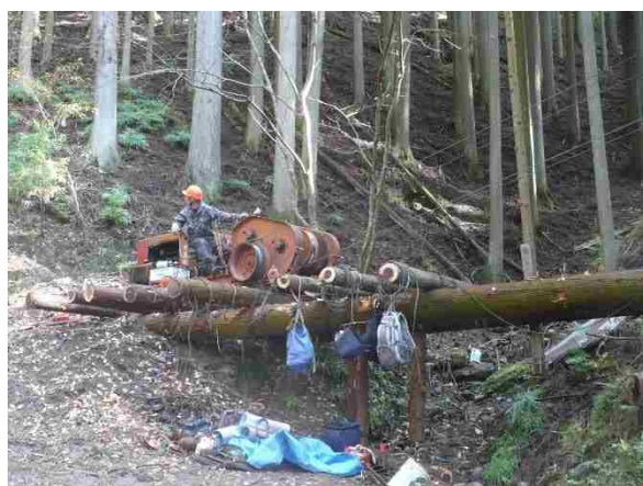
図 5 -23 南丹市で稼働している架線系作業システムの例（写真提供：八木町森林組合）
