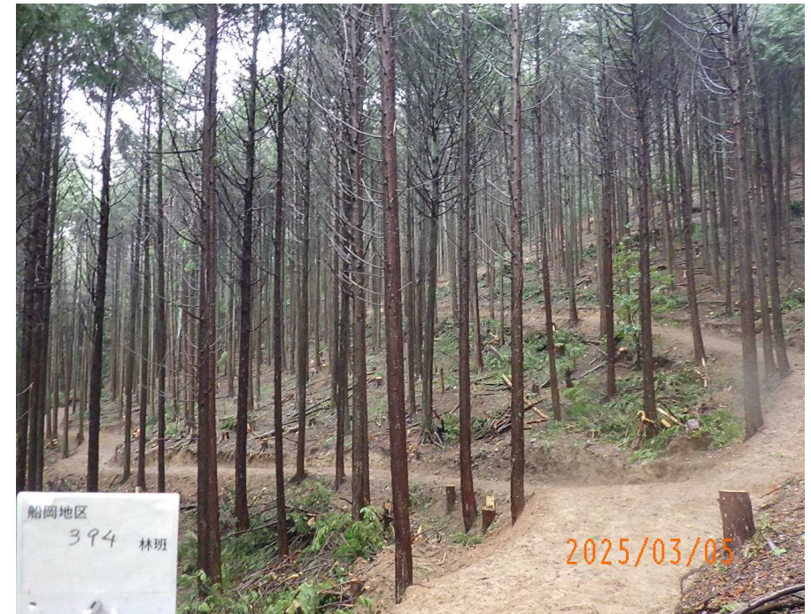
意向調査により実施した 森林作業道の開設と間伐を実施
