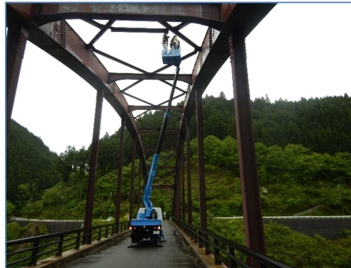
【高所作業車による点検状況】
