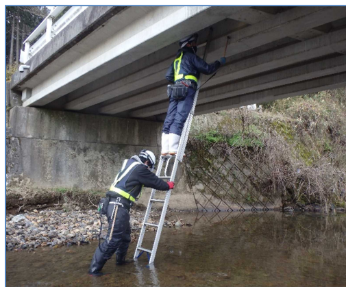
【梯子による点検状況】
