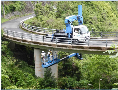
【橋梁点検車による点検状況】
