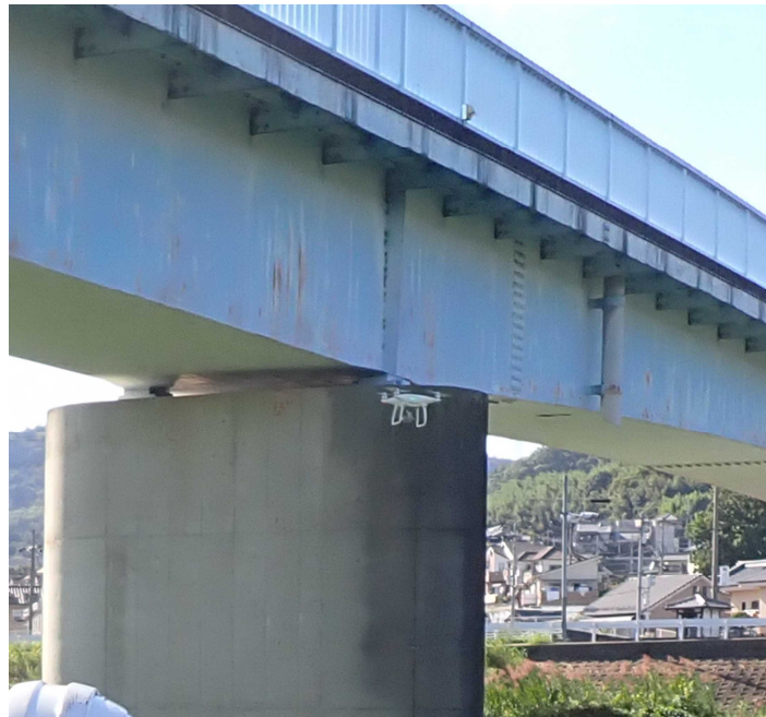
新技術を活用した点検状況
