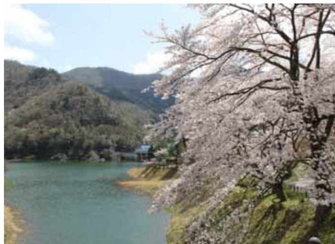
京都府景観資産に登録された大野ダム周辺
