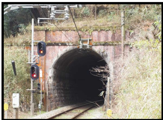
橋梁から船岡駅へ抜けるトンネル
