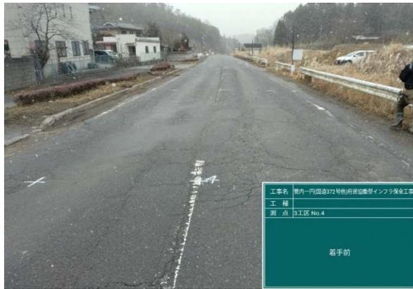
舗装がひび割れ、ラインが消えている
