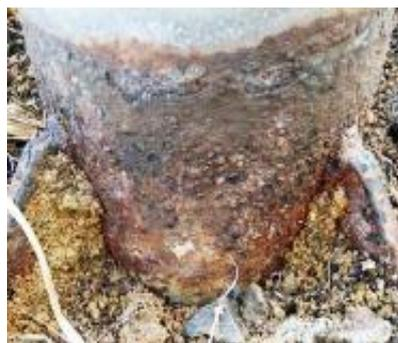
標識柱の根元が錆びている
