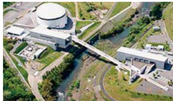
木質バイオマスボイラー設置予定のスプリングスひよし
