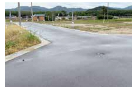
整備された道路
