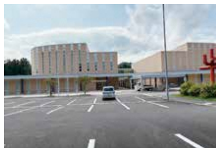
改修が完了した日吉生涯学習センター
