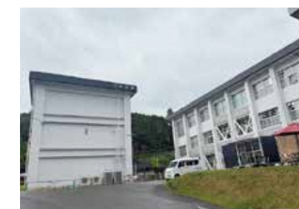
耐震改修された市役所1.2号庁舎
